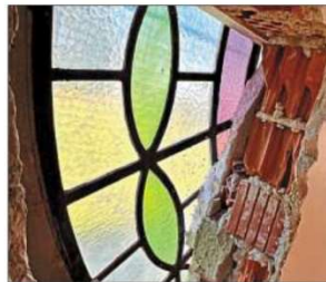
Das historische Rundfenster , das nur von außen an der Ostseite noch zu sehen ist, könnte im Zuge der Umbauarbeiten wieder freigelegt werden. Ein Teil der Mauer wurde probenhalber schon mal weggeschlagen, das bunte Fensterglas ist bestens erhalten.
