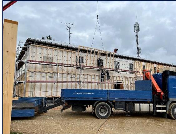
Mit einem großen LKW-Kran heben die Zimmerer die passgenau vorgefertigten Holzrahmenelemente der Dämmwände an die exakte Position. Sie werden sofort an der Jahnhalle fixiert.
