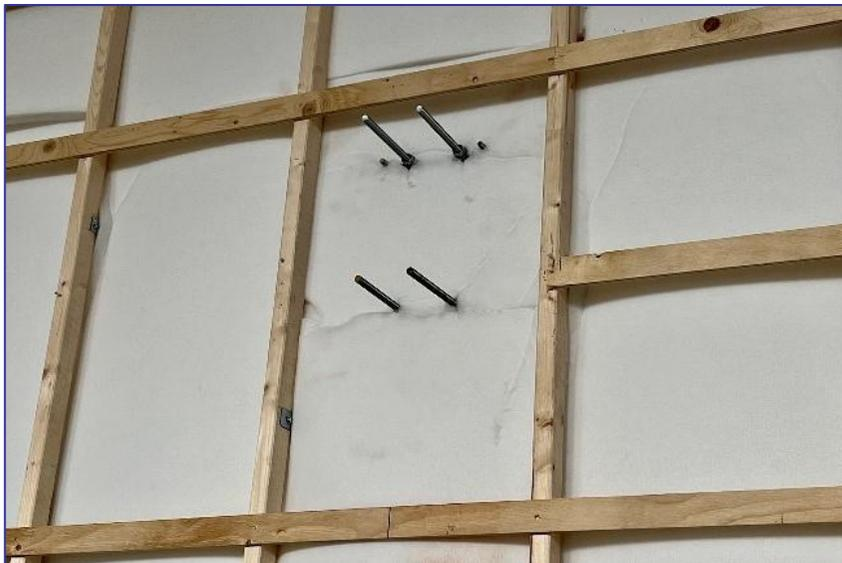
Auch die Zimmerer müssen nur noch wenige Wände verschließen. Mit dieser einfachen, aber sehr effektiven Methode kann die Dämmwolle von großen Rollen passgenau abgeschnitten werden.
