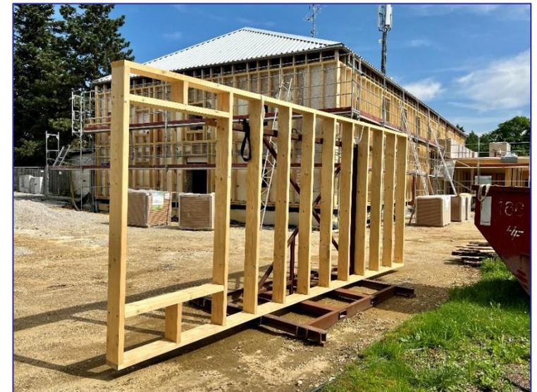
Das letzte Dämm-Holzrahmenelement wartet auf den Einbau.
