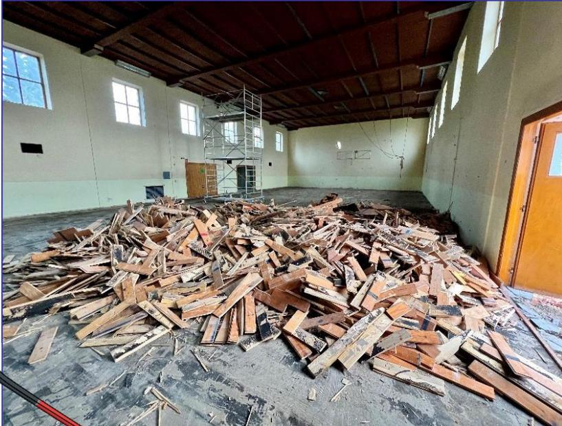
Die Dämmung über der Decke ist ausgebaut, die Holzdecke wird demontiert - man kann das Dachgebälk bereits sehen.
