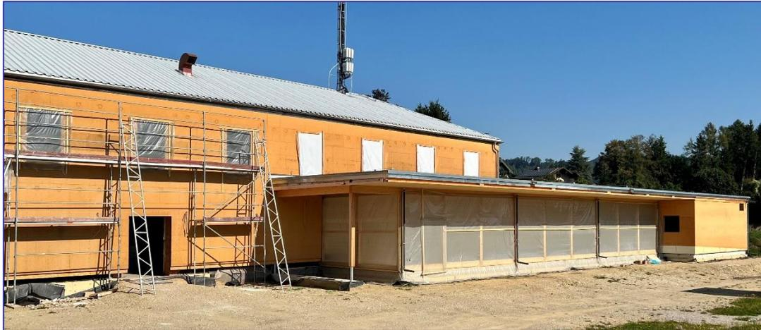
Um aber trotzdem wenigstens mit dem Innenausbau weitermachen zu können, wurden die fehlenden Fenster durch stabile Plastikplanen ersetzt. Damit können die Innenarbeiten fortgeführt werden. Die Grunddämmung ist bereits verlegt, in dieser Woche wird die Fußbodenheizung installiert und auch der Estrich soll bis Freitag eingebracht werden.
