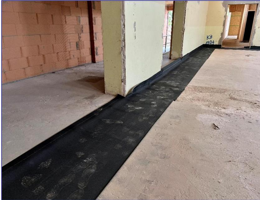
Für die Unterkonstruktion der Prallwand muss der Hallenboden vorbereitet werden.
