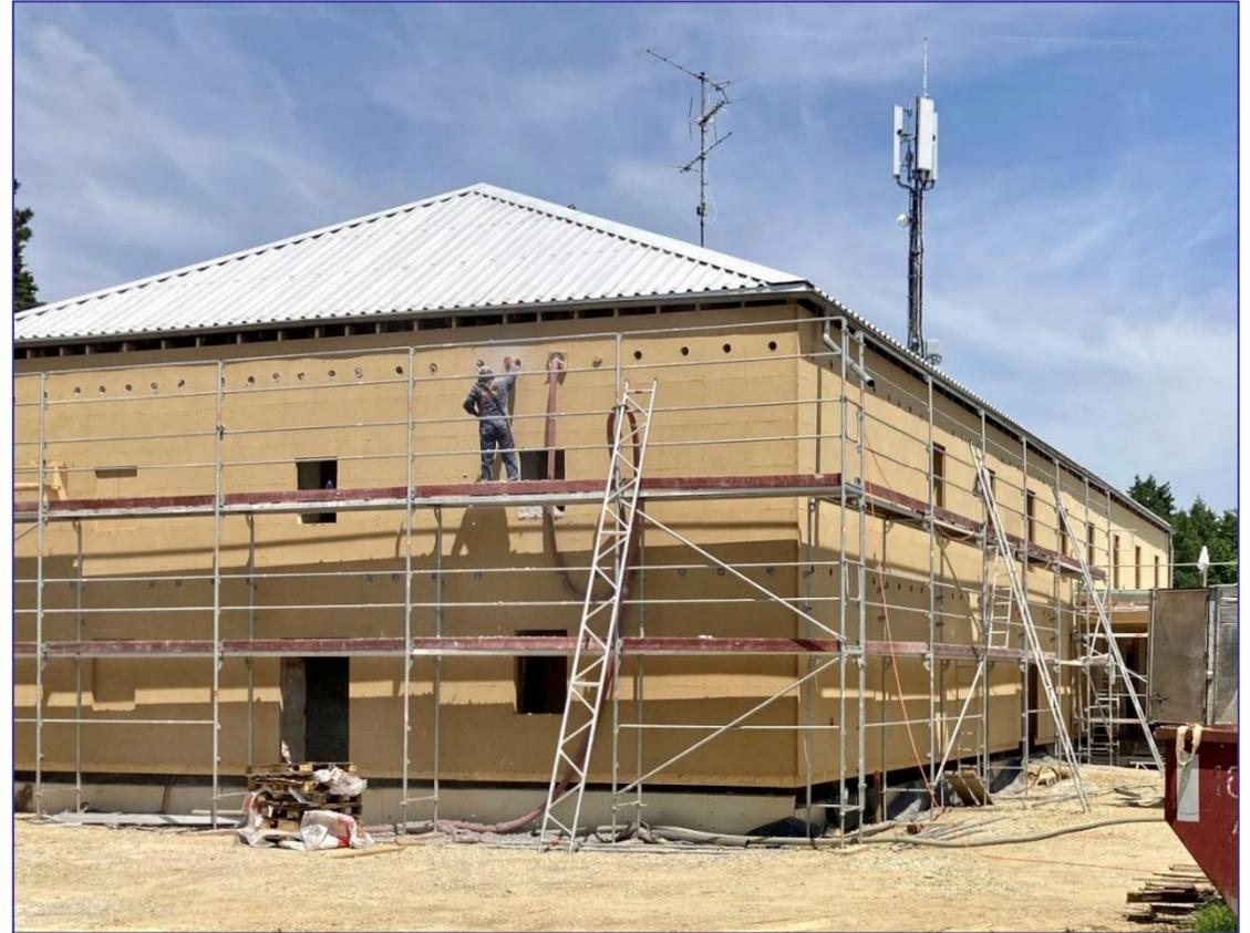
Die Zellulose-Wärmedämmung wird eingeblasen. Ein Spezial-LKW ist vorgefahren, aus ihm verläuft ein langer flexibler Schlauch. Die noch leeren Hohlräume hinter den Holzfaserplatten werden vorab angebohrt und mit Hilfe der Schlauchleitung mit der zerkleinerten Zellulose gefüllt. Beim Einblasen verdichten sich die losen Flocken so lange, bis sich ein fugenloser Block bildet, der den Hohlraum komplett ausfüllt. Dann werden die Holzfaserplatten mit einem passenden Stöpsel dicht verschlossen.
