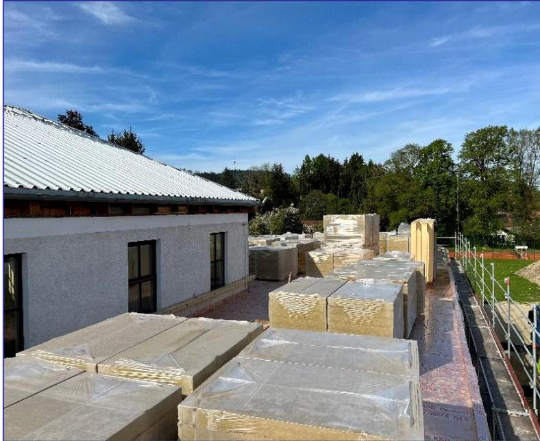
Das neue bereits mit der untersten Trocken-Bitumenfolie (1) abgedichtete Dach ist mit zahlreichen Paletten mit Dämmstoff vollgestellt. Dieser wird alsbald die zweite Schicht der Dachkonstruktion (2) bilden.
