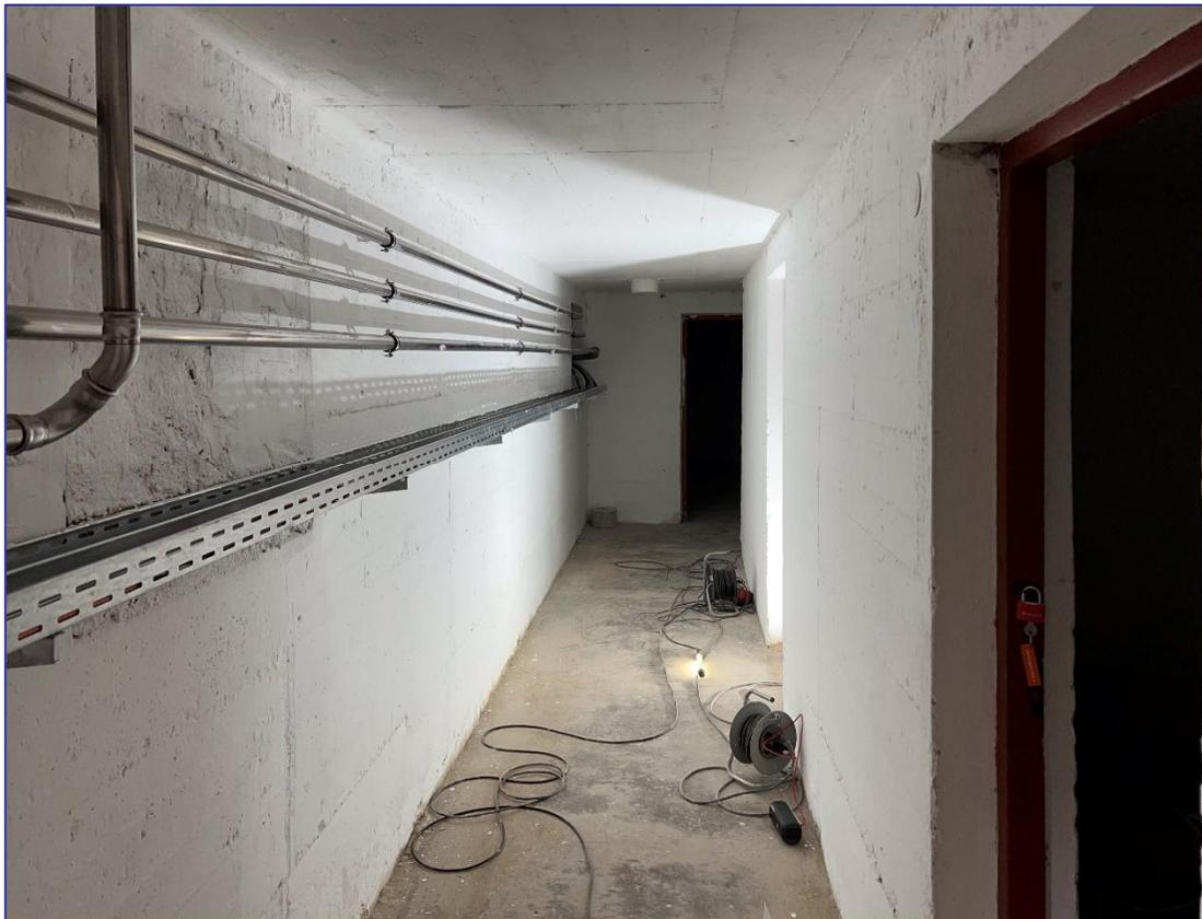
An der Kellerwand verlaufen die Heizungsrohre und Elektroleitungen in den Neubau. Sie stellen die technische Verbindung der beiden Gebäude dar.
