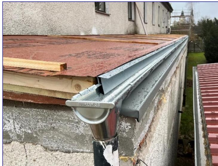
Auch eine In-Gesims-Rinne ist schon auf dem Dach montiert. Das Blechdach dieses Gebäudeteils wird erst später montiert, die Wasserdichtigkeit wird bereits durch eine geeignete Folie gewährleistet.
