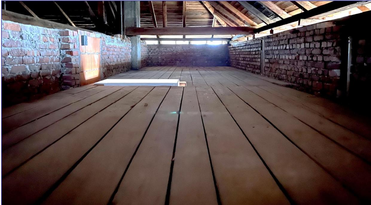
Im Boden sieht man die neu eingebaute Speichertreppe, die den verschärften Feuerschutz-Richtlinien entspricht. Rechts in der Ziegelwand kann man noch die zugemauerte Luke zur Jahnhalle erkennen. Früher musste man von der Halle aus erst das Gemälde von Turnvater Jahn zur Seite schieben, um über eine Leiter in den Speicher zu kriechen.
