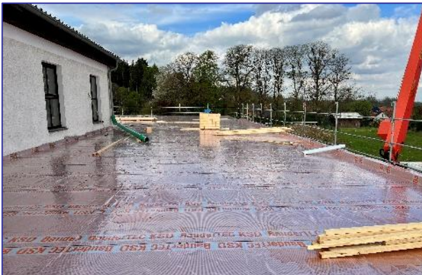
Das Flachdach ist mit einer Spezial-Folie abgedichtet.
