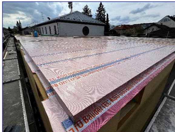
Das Flachdach ist mit einer Spezial-Folie abgedichtet.
