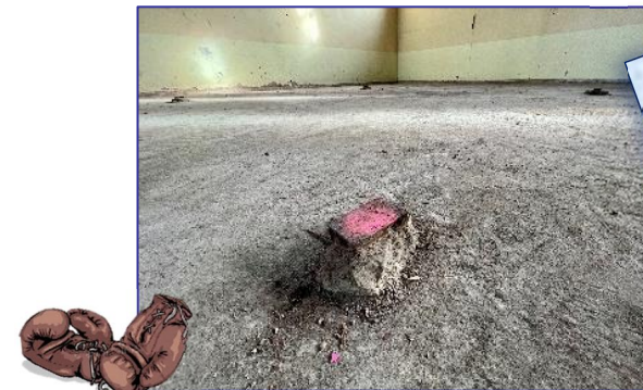
Im Boden sieht man alte Bodenröhren für einen Boxring.
