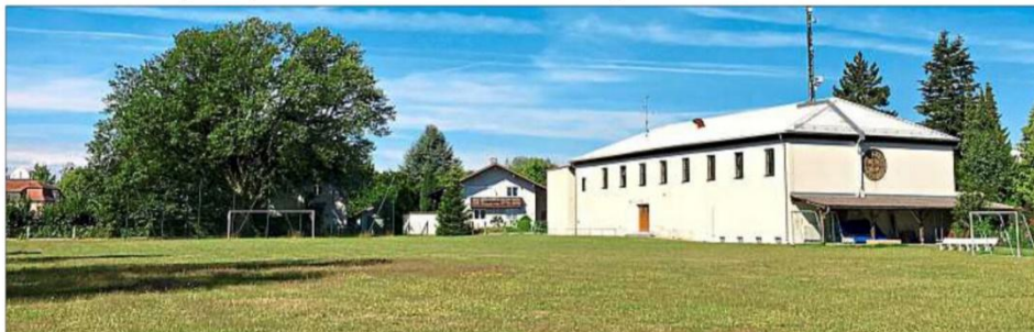
Hier soll ein richtiger kleiner Stadtteil entstehen: Die in die Jahre gekommene Jahnturnhalle (rechts) soll saniert werden und ein kleiner Rasenplatz für Sport soll ebenfalls bleiben. Auf dem restlichen Grundstück könnten Einfamilienhäuser entstehen mit einer kleinen Grünanlage in der Mitte, die die Luitpold-Eiche (links) miteinschließt.
