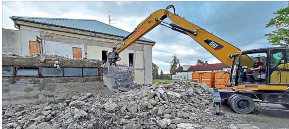
Dem Erdboden gleich gemacht wurde die alte Hausmeister-Wohnung.
