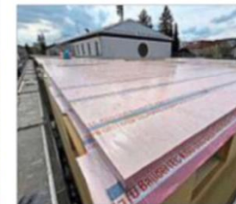
Bereits abgedichtet ist das Dach des Neubaus. Jetzt können Wolkenbrüche nichts mehr anrichten.
