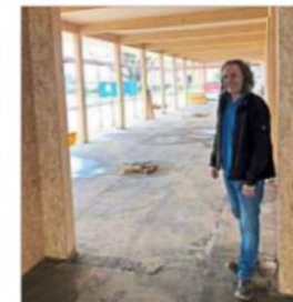
Vorsitzender Dr. Stephan Gaisbauer freut sich über den Verlauf der Baustelle. Er steht im Eingangsbereich zum Begegnungszentrum.
