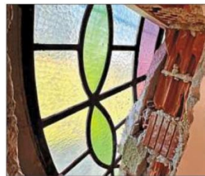
Das historische Rundfenster , das nur von außen an der Ostseite noch zu sehen ist, könnte im Zuge der Umbauarbeiten wieder freigelegt werden. Ein Teil der Mauer wurde probierhalber schon mal weggeschlagen, das bunte Fensterglas ist bestens erhalten.
