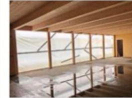
Groß und lichtdurchflutet wird der neue Bewegungsraum bzw. Multifunktionsraum.
