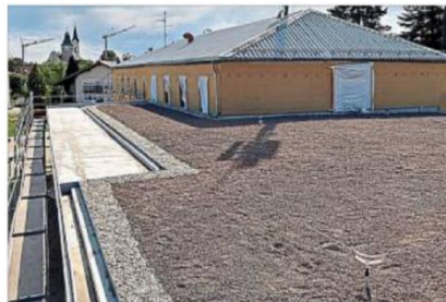
Das Substrat für die Begrünung am neuen Dach ist bereits ausgebracht, jetzt müssen nur noch die Moose, Kräuter und Gräser für die Insekten wachsen.
