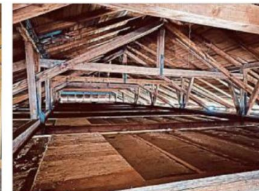
Der Dachstuhl von 1929 ist fertig saniert. Eine neue Decke wurde eingezogen, um die alten Balken darüber zu stützen.
