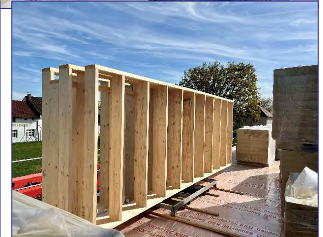
Die Holzrahmenelemente der Dämmwände stehen schon bereit, um an die Jahnhalle montiert zu werden.
