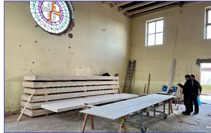
Alle Platten unter dem historischen Rundfenster müssen noch an die Decke.
