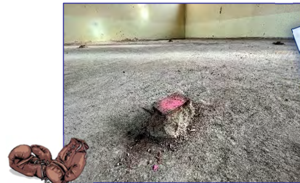
Im Boden sieht man alte Bodenröhren für einen Boxing.
