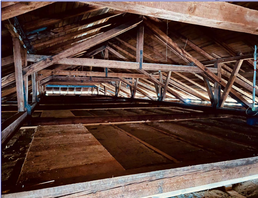
Ein Blick vom Dachstuhl aus auf die isolierte neue Holzdecke.
