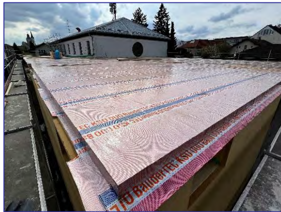
Das Flachdach ist mit einer Spezial-Folie abgedichtet.
