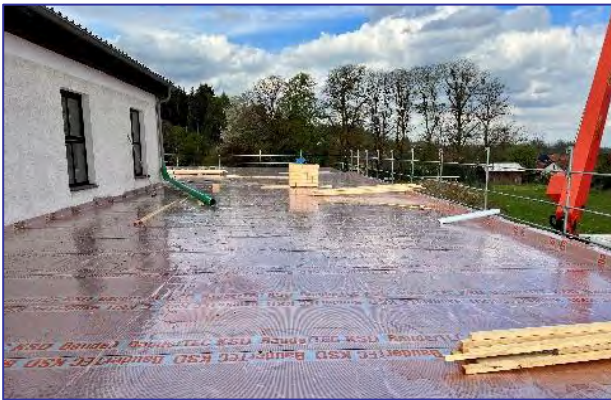
Das Flachdach ist mit einer Spezial-Folie abgedichtet.
