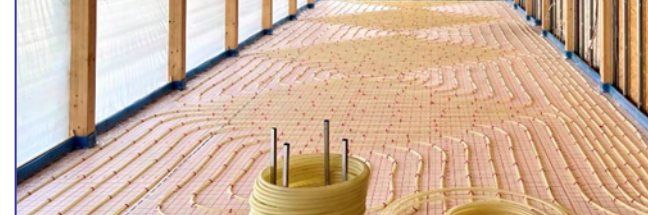
Schneckenförmig gelegte Polyethylen-Heizrohre
