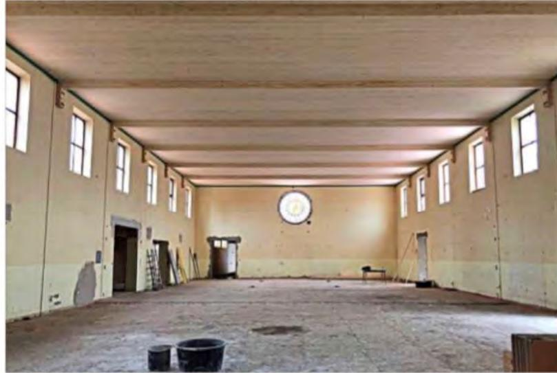
**Unten Rohbau, oben neue Decke:** So sah es vor einer Woche in der Jahnturnhalle aus. Als nächstes kommen die neuen Prallschutzwände und dann geht es an den Bodenaufbau. – Fotos: Brodschelm
